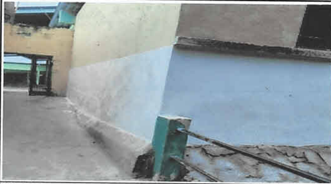
FOTO 1: IMPERMIABILIZACION DE PARED TERMINADA
