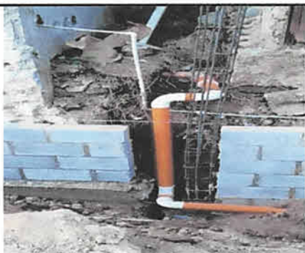
FOTO 5: DRENAJE EN FUNCIONES
