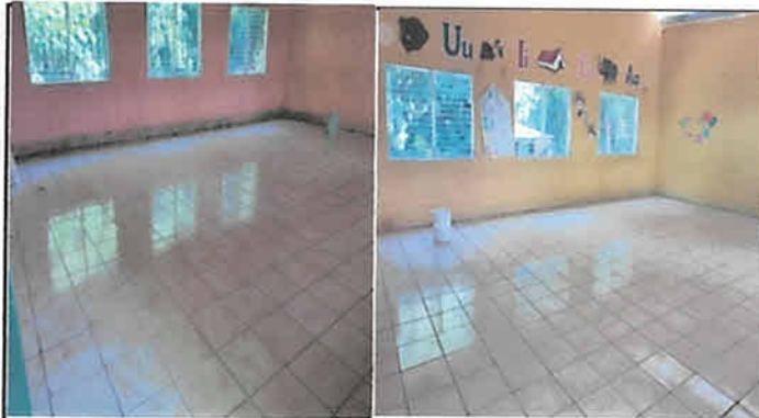
FOTO 3: CERAMICO EN AULAS
