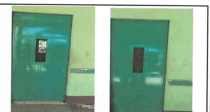
FOTO: 6 SUSTITUCION DE 2 PUERTAS DE AULAS
