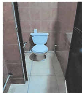
FOTO 2: REPARACION DE SANITARIOS
