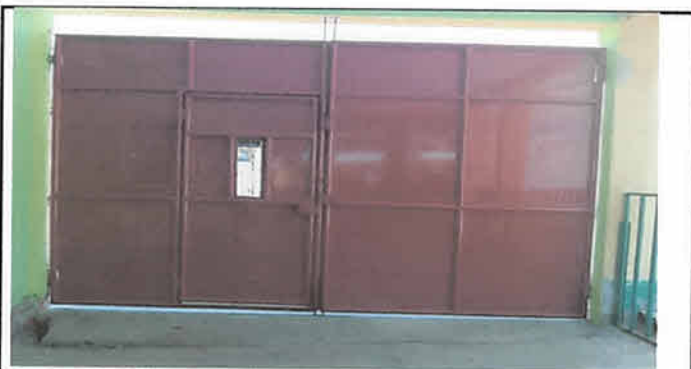
FOTO 5. SUSTITUCION DE PORTON ENTRADA PRINCIPAL
