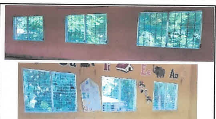
FOTO 4: INSTALACION DE VENTANAS DE ALUMNIO Y PALETAS DE VIDRIO
