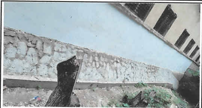
FOTO 2: REZANADO DE PARED EXTERIOR DE AULAS FINALIZADO
