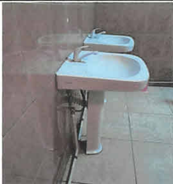
FOTO 1: REPARACION DE LAVAMANOS
